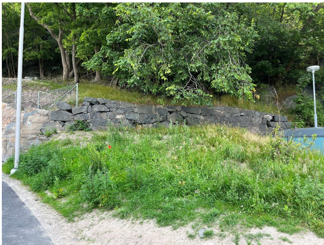
Figur 69. Befintlig kallmur bakom återvinningscentral mot berget sett från Fjällgatan. (bildkälla: platsbesök 250702)
