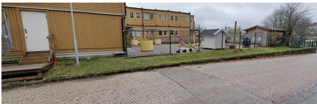
Figur 31 Befintlig stödmur längs med vägens östra sida, tillfälliga baracker för förskola syns bakom slänten. (Bildkälla Google maps 2025)
