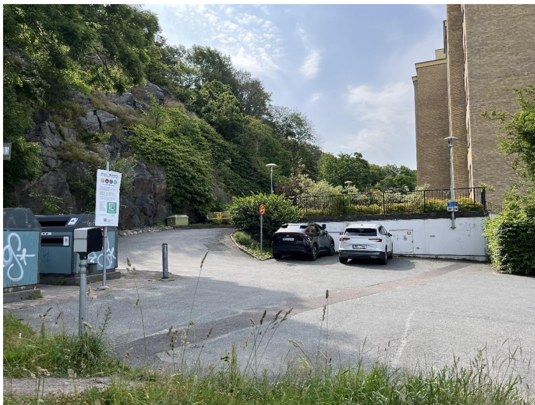
Figur 68. Befintlig uppfart till Stigberget 32:1, parkeringsgaragetets gavel mot Fjällgatan syns i vitt till höger, bild tagen från Fjällgatan (bildkälla platsbesök 250702)
