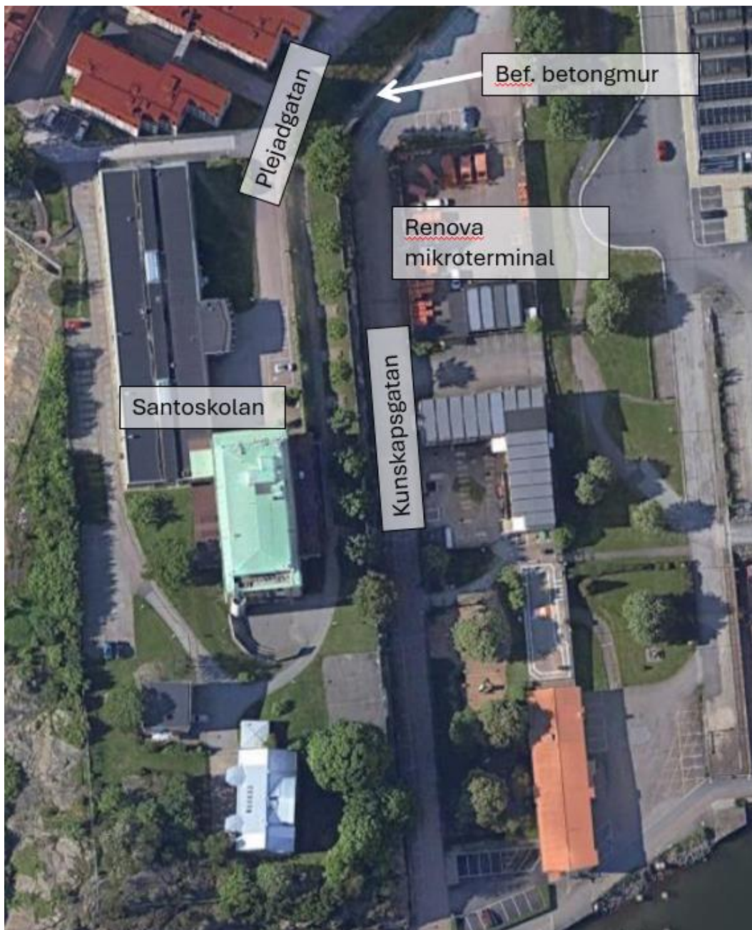
Figur 27. Översiktsbild befintliga konstruktioner på det aktuella området (Bildkälla Google maps 2025)
